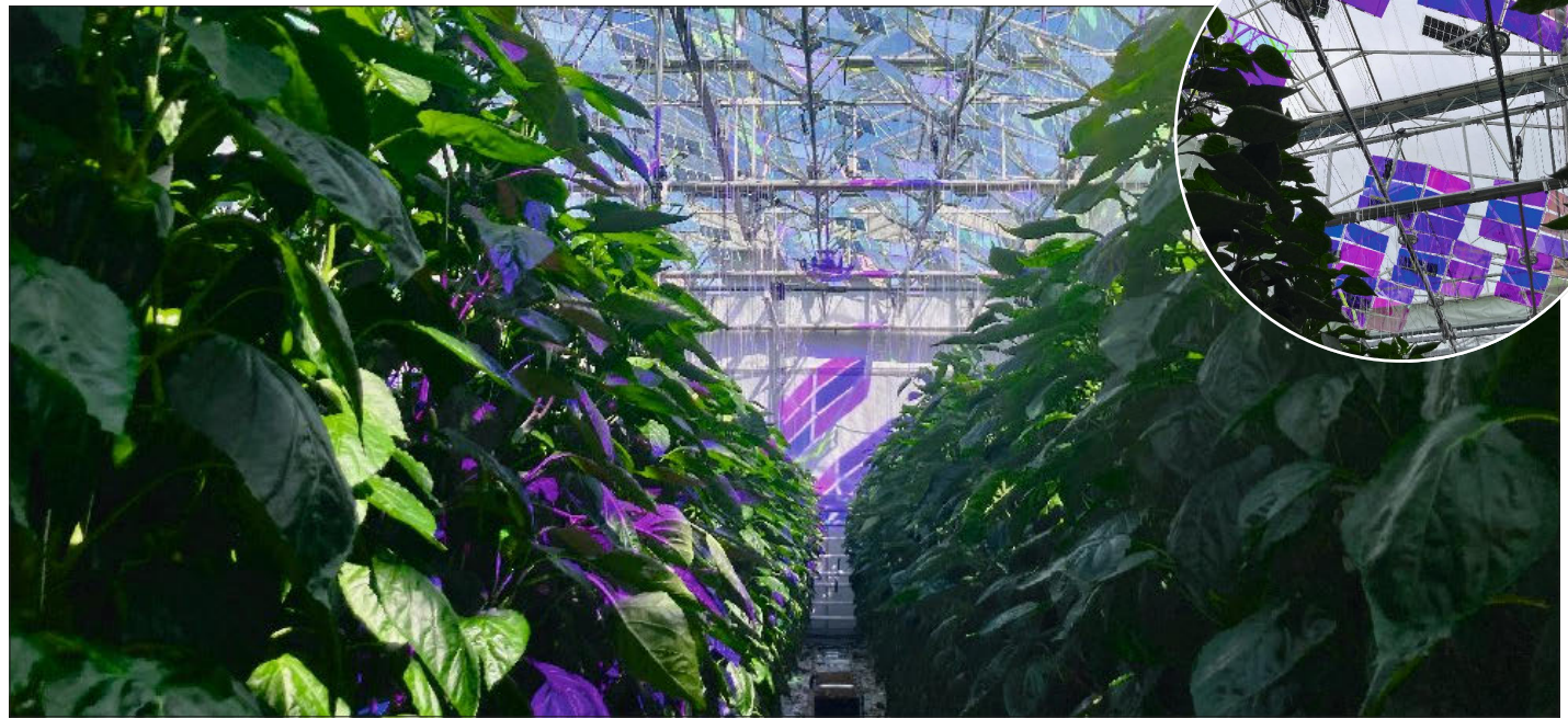
Photovoltaik-Lösung von Voltiris: Im Gewächshaus installierte Spiegel reflektieren das Licht auf ein kleineres Solarmodul. Fotos: Voltiris
